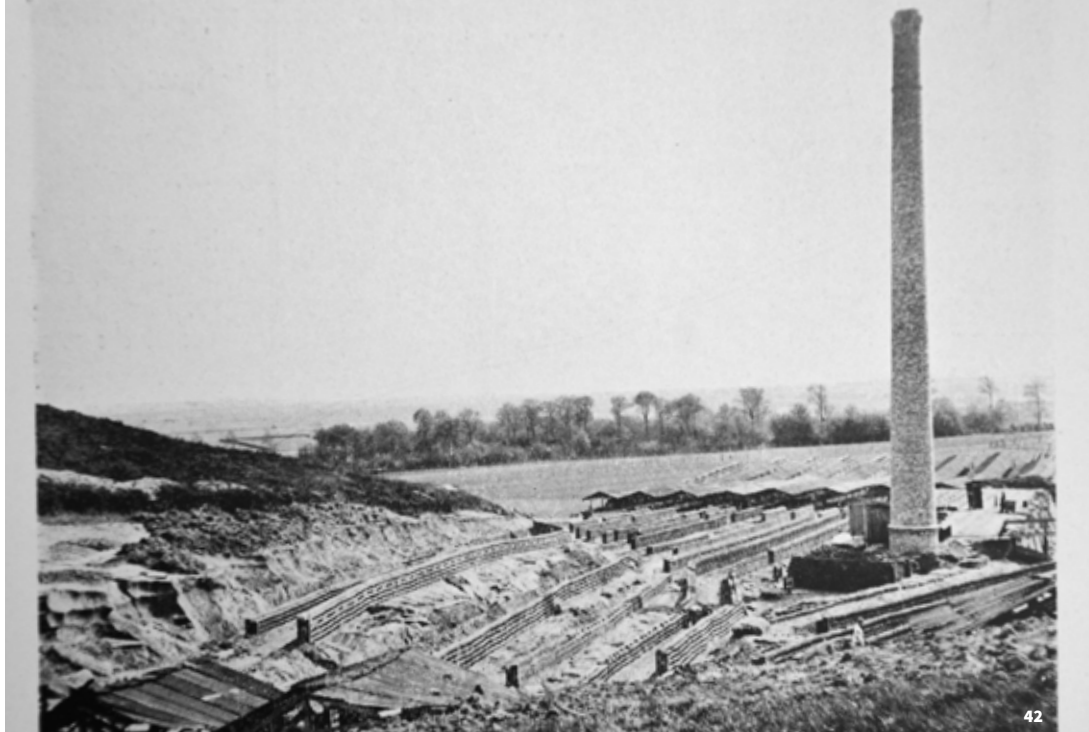
42 : Briquetterie construite sur place pour alimenter le chantier de construction. Archives Départementales du Pas-de-Calais, Le Monument Illustré , BHD 22-3.
