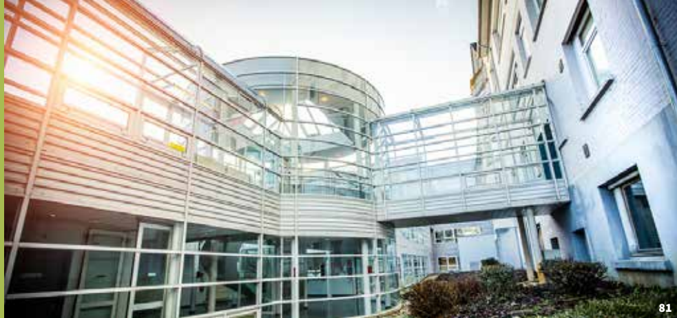
81 : Articulation entre l'ancien sanatorium et la partie contemporaine de l'établissement.
